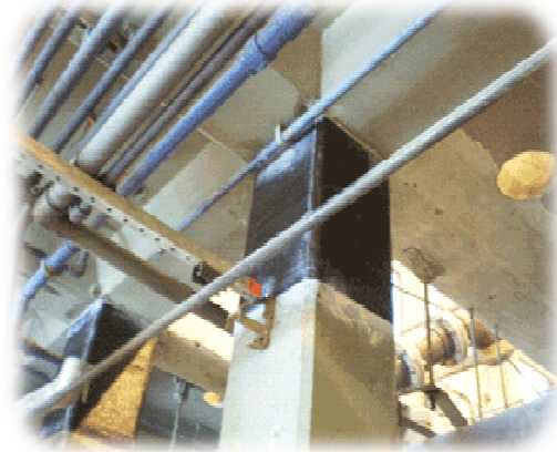
Σχήμα 4: Ενίσχυση Κ.Π. υποστυλώματος με FRP [5].
