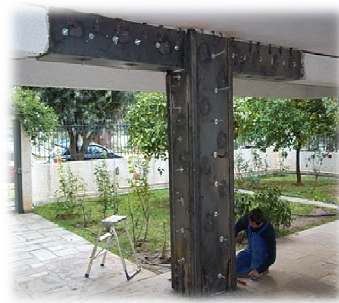
Σχήμα 2: Χαλύβδινος μανδύας σε υποστύλωμα-δοκό[4].
