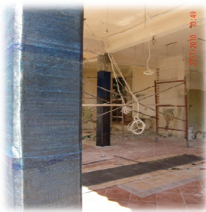
Σχήμα 1: Ολόσωμος μανδύας ΙΟΠ με ίνες άνθρακα [4].
