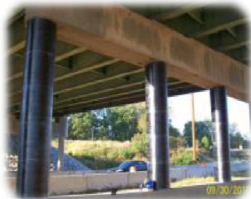
Σχήμα 3: Ενίσχυση υποστυλωμάτων με FRP [5].
